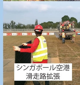
作業通路養生
